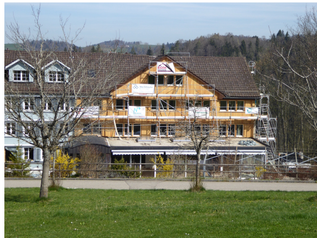
Ostteil in der neuen Hülle aus Lärchenholz
