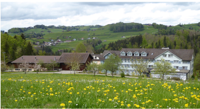
Liegenschaft inklusive Landwirtschaftsgebäude vor dem Umbau
