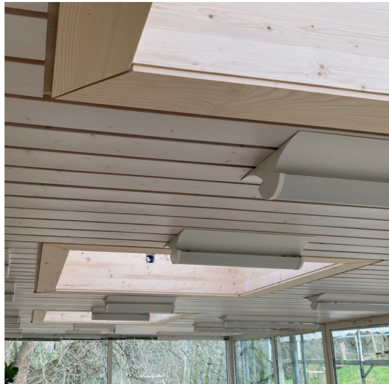
Erneuerung der Kuppel-Oberlichter sowie der Holzverkleidung
