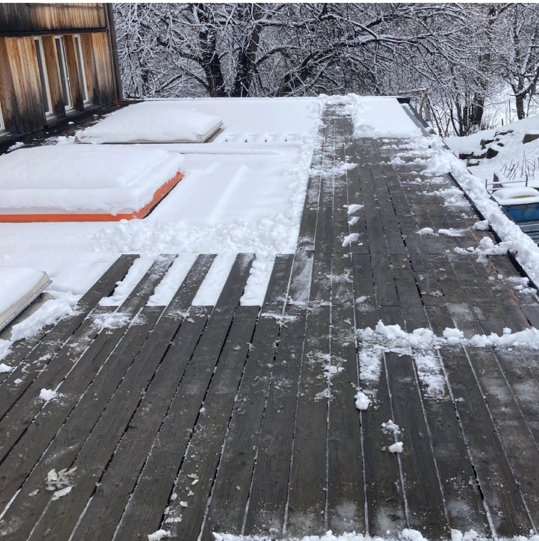
Weisse Überraschung während der Demontage des Terrassenbodens
